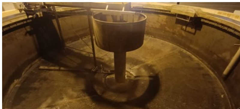
Fond de la cuve qui a été vidée où apparaît le racleur qui a été réparé.
