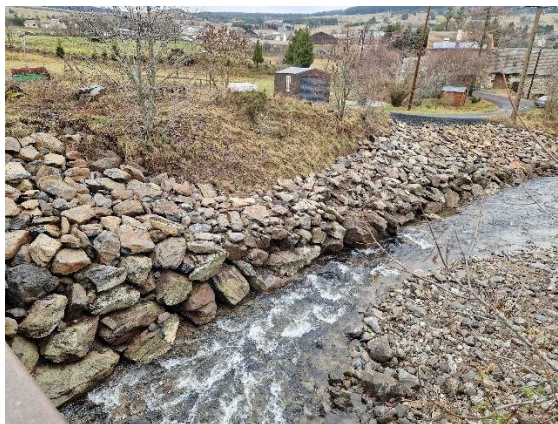
Enrochement sous le pont du moulin le long de la Gazeille
