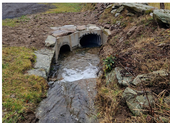
Le chemin de la Marcelline a été goudronné et le passage busé à été doublé pour palier aux crues.
