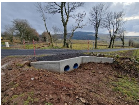
Au croisement des chemins de Merle et Guillaumet, les buses dégradées d'un diamètre de 400 à l'origine ont été remplacées par des 600 en tuyau annelé.
