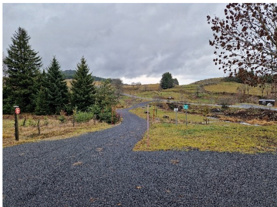
Le chemin d'accès à la maison de Revenet a été goudronné de même que le départ du chemin des Ogiris sur 50 m
