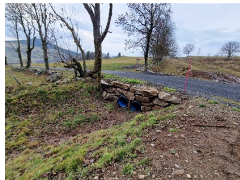
Au croisement des chemins de Merle et Guillaumet, les buses dégradées d'un diamètre de 400 à l'origine ont été remplacées par des 600 en tuyau annelé.
